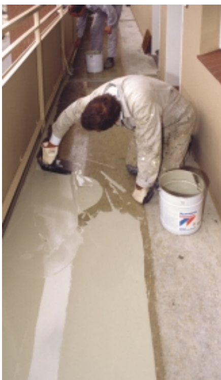
Beschichtung eines Laubenganges
