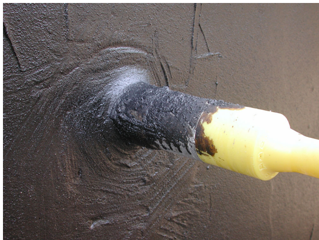
Bild 7: Detail Rohrdurchführung mit Hohlkehle
