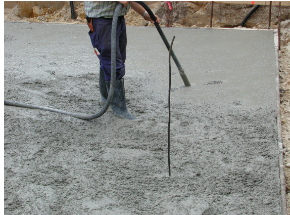
Bild 2: Einbau und Verdichten des Betons
