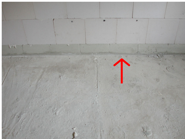
Bild 9: Innenansicht der Kelleraußenwand; „Blockabdichtung“ der ersten Steinschicht H = 12,5 cm mit 2 Verkieselungsfolgen
