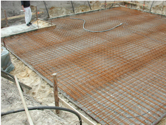
Bild 1: Fundamentplatte vor der Betonage
