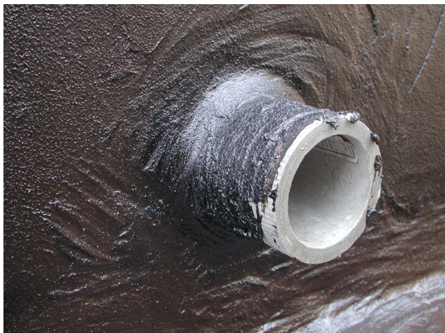
Bild 6: Detail Rohrdurchführung mit Hohlkehle
