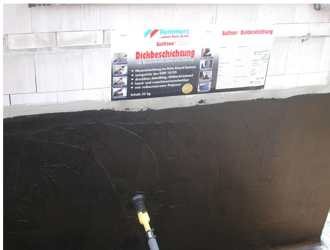
Bild 5: Fertig hergestellte Abdichtung vor dem Anbringen des Schutzes
