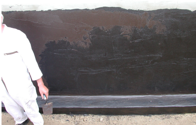
Bild 4: Auftragen der zweiten Schicht (im frischen Zustand braun) nach dem vollständigen Austrocknen der ersten Schicht (schwarz)
