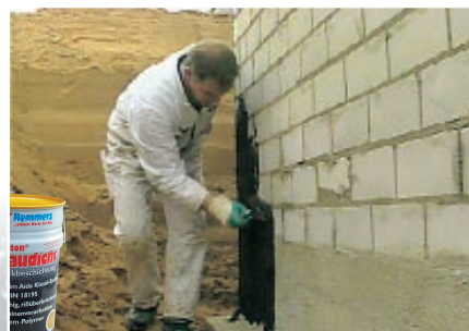
8. „Schwarz sehen“? Ganz im Gegenteil: Mit Sulfiton Dickbeschichtung oder Sulfiton Profi Baudicht wird nun die komplette Kellerwand inkl. Sockel in zwei Arbeitsgängen abgespachtelt.
