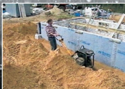
11. Die Außenabdichtung ist fertig. Jetzt wird gegebenenfalls die Drainage verlegt und die Baugrube lagenweise verfüllt und verdichtet.
