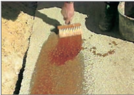
1. Dem Wasser keine Chance: Bevor die erste Steinlage aufgemauert wird, wird im Wandaufsatzbereich 2x abwechselnd Aida Kiesol und Aida ADS Spezialschäume eingestrichen.
