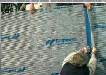
10. Bevor die Baugrube verfüllt wird, die eventuelle Perimeterdämmung aufkleben und als Anfüllschutz und Dränsystem Sulfiton DS Systemschutz einbauen.
