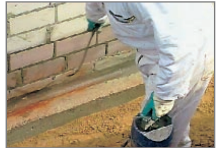
6. Sicher ist sicher: Nochmaliges Einsprühen von Aida Kiesol, damit die nachfolgende Aida ADS Spezialschlämme sicher haften.
