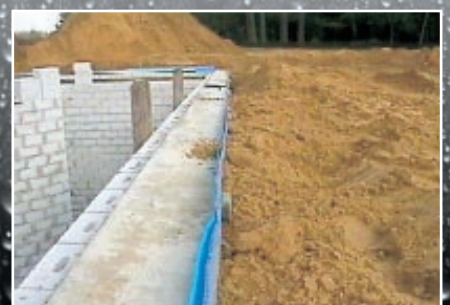
12. Das hält garantiert: Die Kellerwand ist bis zur Oberkante hin geschützt, das Erdreich ist komplett angefüllt und verdichtet.
