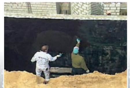
9. "Schwarz wie die Nacht": So muß das Mauerwerk aussehen, nachdem es komplett mit Dickbeschichtung geschützt wurde.
