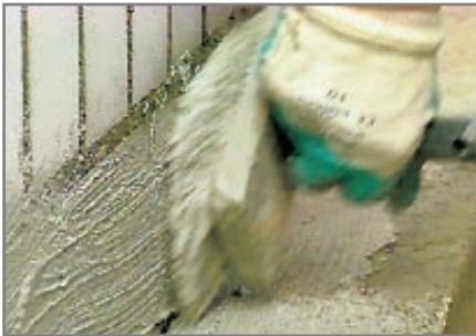
4. Die "Achillesferse" des Mauerwerks: der Wandaufsatzbereich wird mit Aida ADS Spezialschlämme geschützt.
