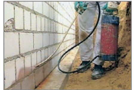
3. Das Mauerwerk steht. Jetzt beginnt die Außenabdichtung, indem zunächst Aida Kiesol aufgesprüht wird.
