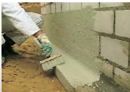
7. Die Seitenfläche der Bodenplatte, der Hohlkehlenbereich und die erste Mauersteinreihe werden komplett eingeschlammmt, um den Auftrag der Dickbeschichtung vorzubereiten.
