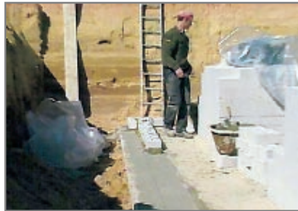
2. Die Streifenabdichtung ist ausgeführt: Das Mauerwerk kann "hochgezogen" werden.
