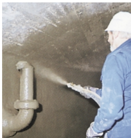
Spritzverarbeitung von Aida ADS Trinkwasserschlämme mit Feinputzmaschine (Doppelkolbenpumpe P 13).
