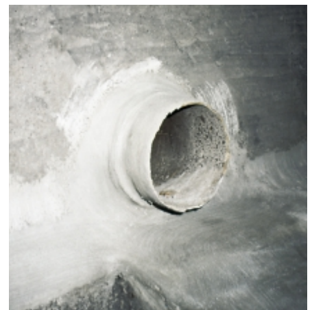
Vorarbeiten im Wand-/Bodenbereich mit neuer Dichtungskehle und Ausgleichsschicht.
