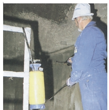
Vollflächiges Übersprühen zum Abschluß mit Aida Kiesel.
