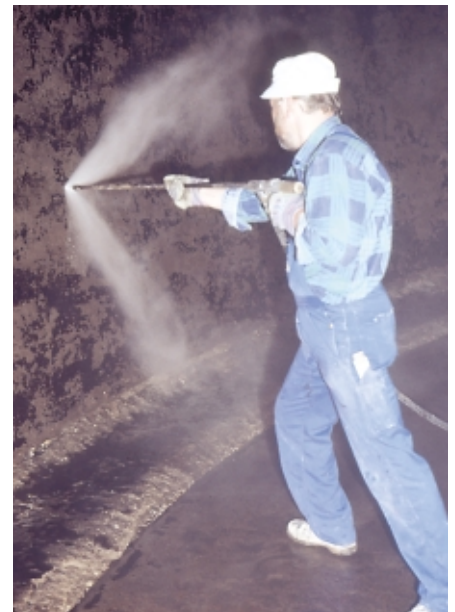
Zerschlagung und Entfernung mürber Schichten mit Höchstdruckwasserstrahlgerät. Leistung ca. 680 Bar.
