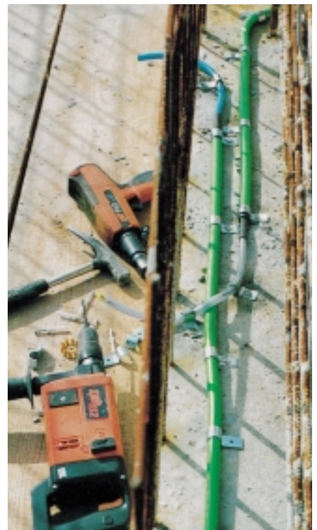
Anwendungsbeispiel: Arbeitsfuge Aufzugsschacht mit muster-gültiger Stoßüberlappung.
