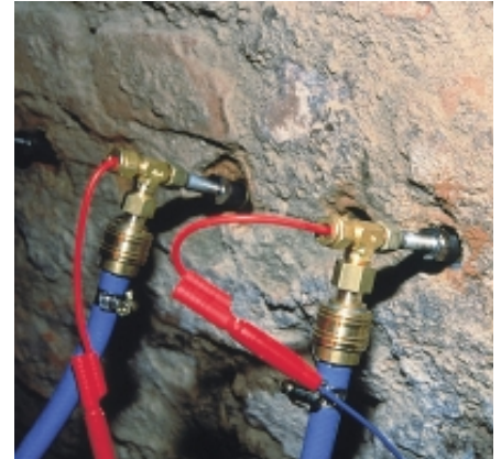
Heizpacker eingebaut, jedes 2. Bohrloch
