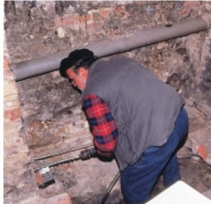
Herstellung der Bohrlöcher
